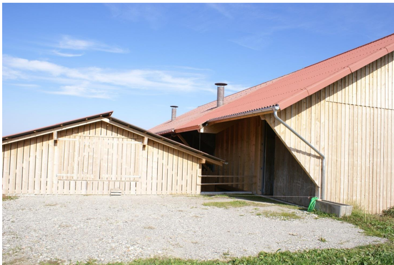
Anbau Liegehalle, Wolfhalden
