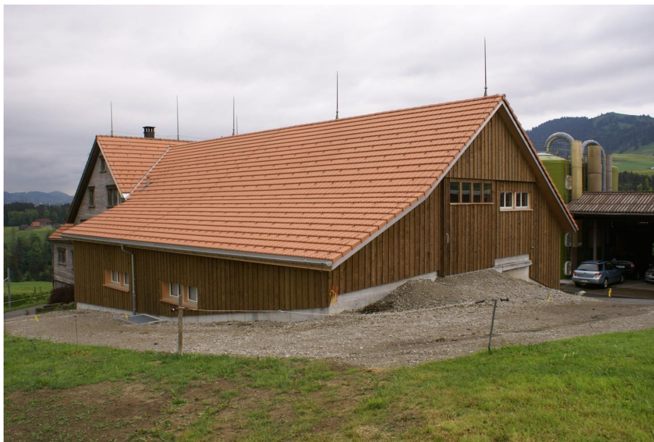
Neubau Remise / Jauchegrube, Waldstatt
