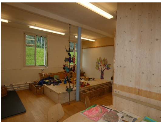
Abbildung 12 + 13: Links: Stahlrundstützen im Anbau (heute: Kinderbetreuung); rechts: alte Verstärkungsplatten an der Decke aus Flachstahlelementen.
