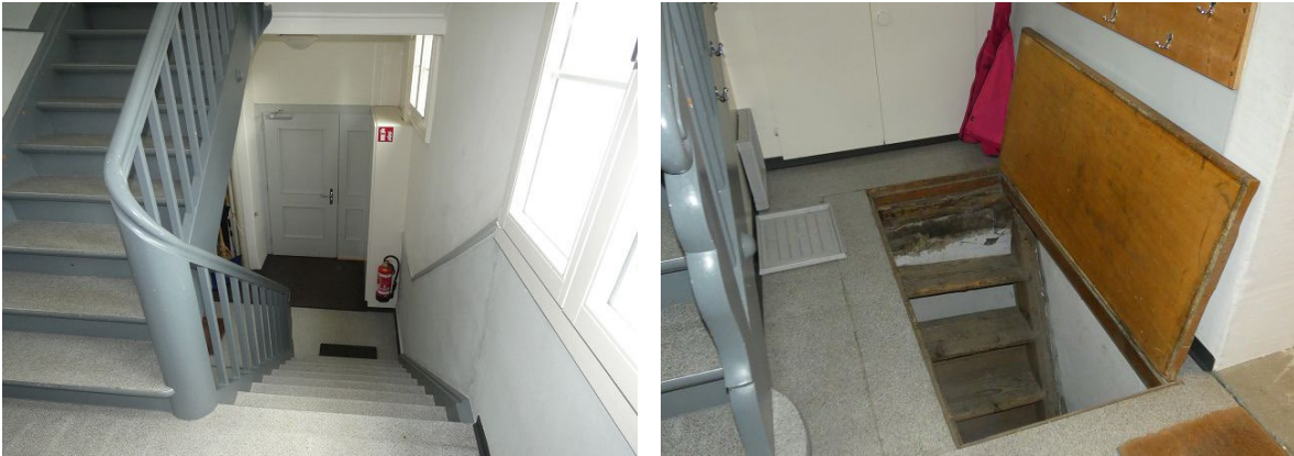
Abbildung 32 + 33: Links: Haupttreppenhaus; rechts: Lukenzugang zu Kellerbereich.
