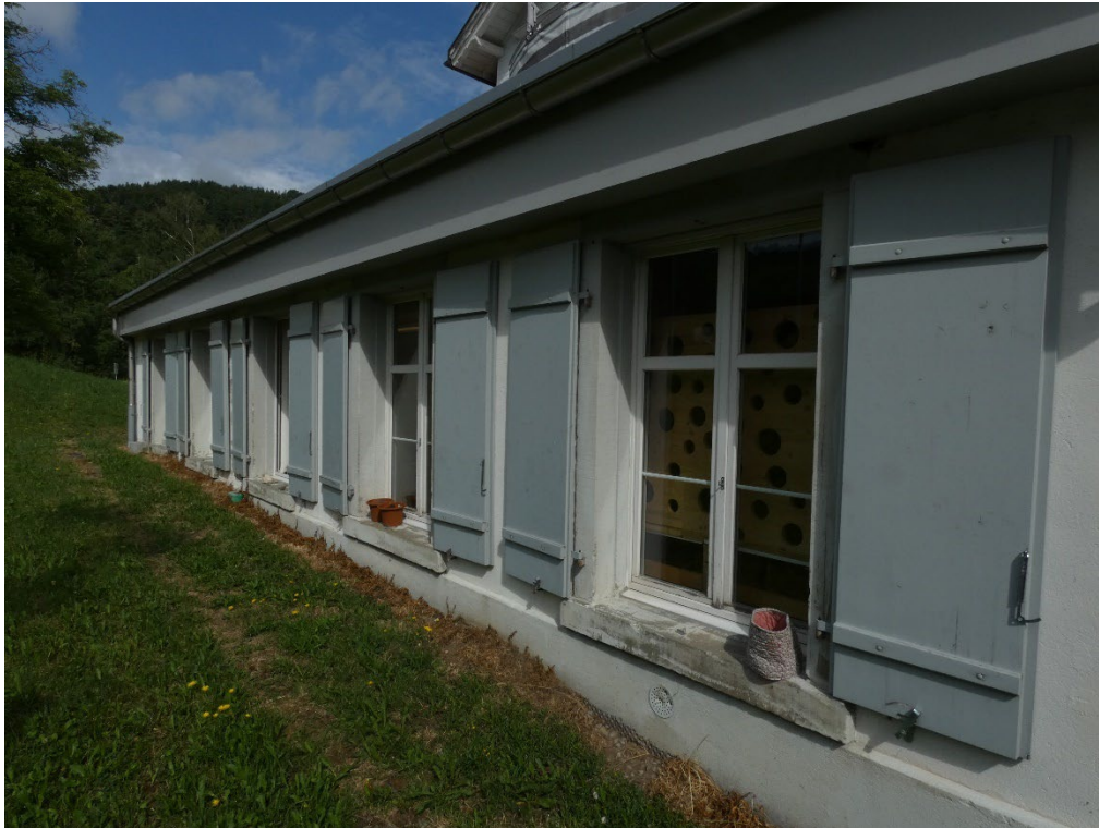
Südseite Anbau (Kinderbetreuung) mit angeschüttetem Gelände
