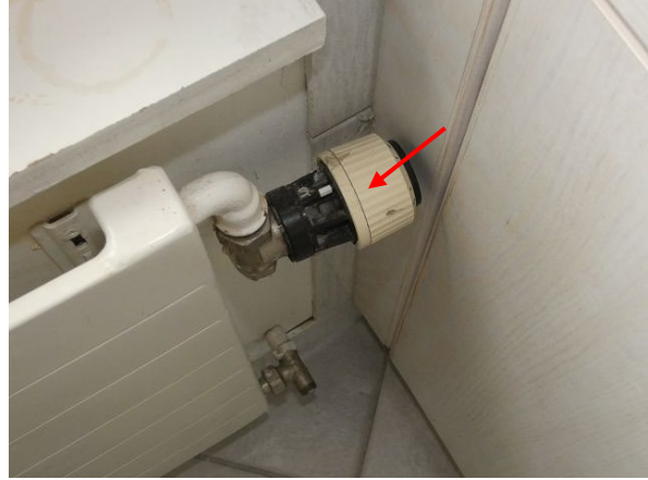
Abbildung 26 + 27: Links: Warmwasserspeicher im Keller, rechts: veraltete Heizkörperthermostate.
