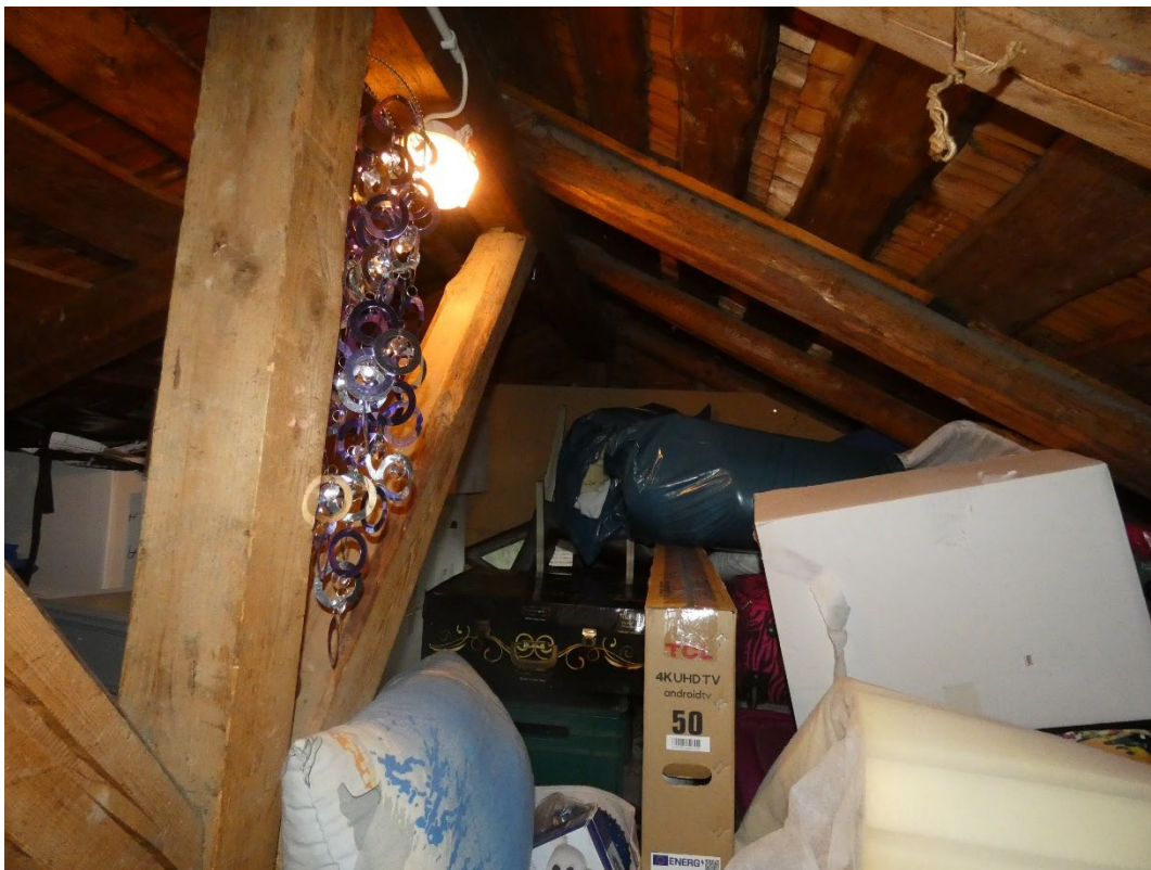
Dachstuhl im Gaubenbereich
