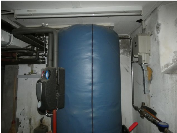
Abbildung 26 + 27: Links: Warmwasserspeicher im Keller, rechts: veraltete Heizkörperthermostate.
