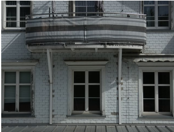
Abbildung 22 + 23: Links: Vorgehängter Balkon an Gebäuderückseite, rechts: Balkon.
