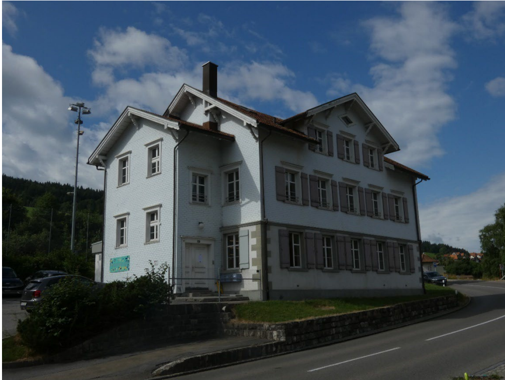
Ansicht von Nordost (Strassenseite)
