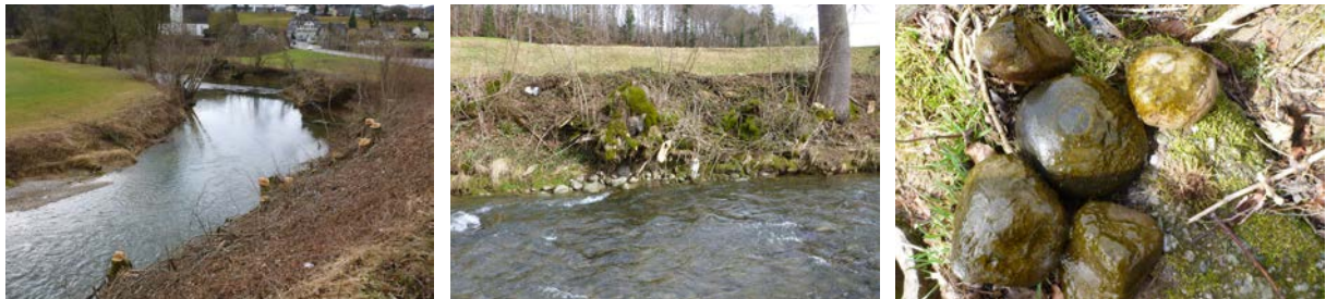
Glatt - Oberbüren-Oberglatt ob ARA Oberglatt (Flawil) - OGT151, Aufnahmen vom 28. Februar 2017
